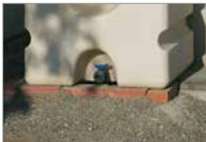
Protection de la vanne, moulée dans la cuve.
