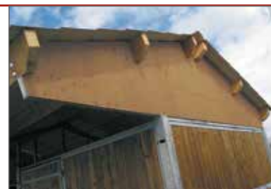
Habillage sous toiture des pignons
