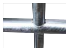
Assemblage des entretoises Ø 42 mm grugées avec gueule de loup sur les lisses de barrière.
