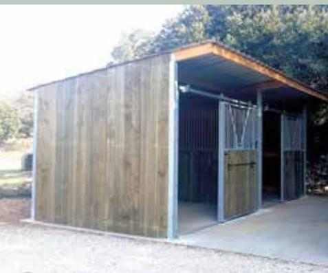
Préconisation de montage et législation : Abris à poser sur dalle béton parfaitement de niveau et d'épaisseur environ 150 mm, utiliser du béton correctement dosé et réalisé dans les règles de l'art.
